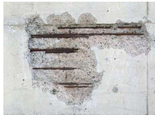
図-3 A1 補修部叩き落し後 近接
