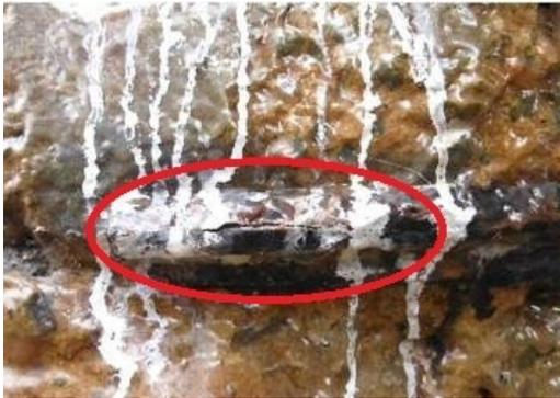
図-14 鋼材腐食に伴う防水塗膜の破断 (A2)
