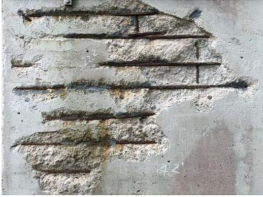
図-5 A2 補修部叩き落し後 近接
