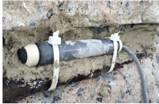
図-7 埋設型照合電極設置状況
