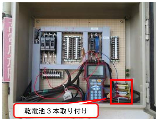
写真-7 乾電池の取り付け状況
