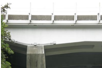
写真-1 施工後の外観
