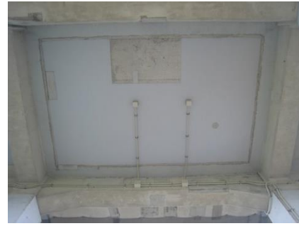
写真-5 区間 1 での施工状況
