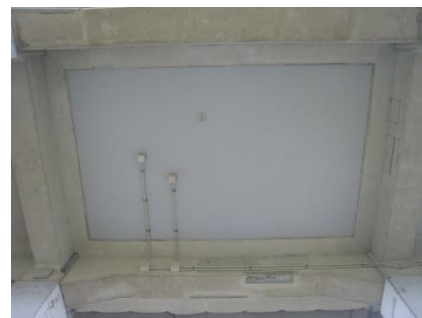
(a) 写真-6 区間 2 での施工状況
