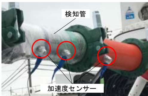
写真-2 配管への加速度センサー設置状況
