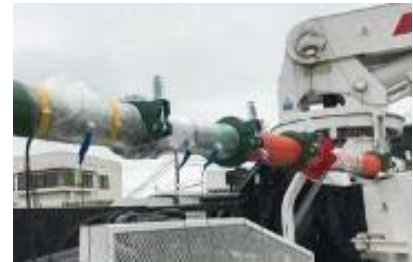
写真-1 車体側配管
