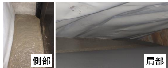
写真-3 高流動コンクリートの流動状況
