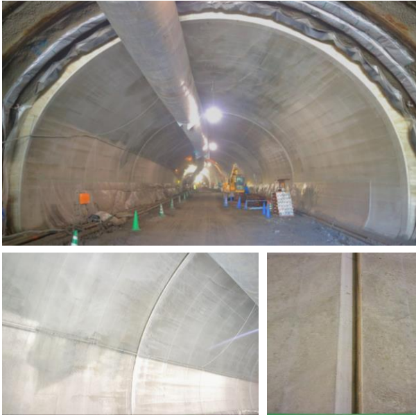
写真-4 一液型混和剤を用いて製造した低セメント量の高流動コンクリートで構築した覆工の外観
