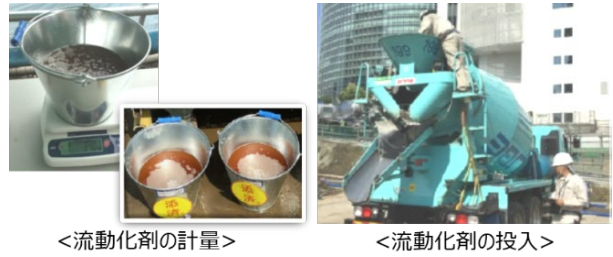
図-11 流動化剤の計量と投入の様子
