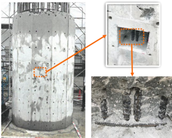
図-10 杭模擬試験体の外観と鉄筋廻りの充填状況
