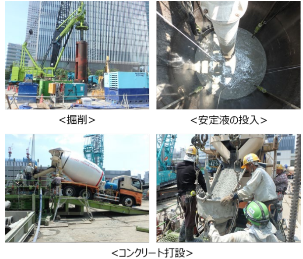
図-12 杭施工工事の状況
