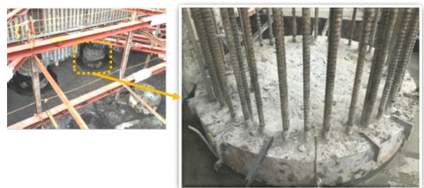
図-18 地下掘削や杭頭の状況
