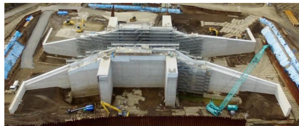
写真-2 水門全景
