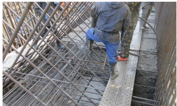
写真-1 打込み状況
