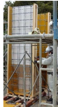
写真-2 実大壁試験体の型枠の組立て
