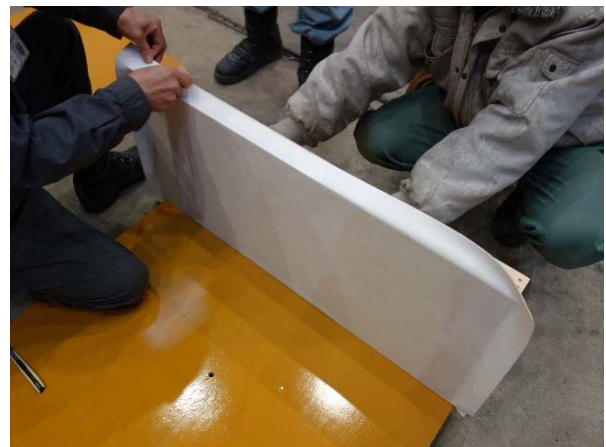
写真-1 型枠材ユニットへの不織布の張付け
