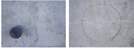
写真-18 天端より 2140mm 縞模様箇所での透気試験
