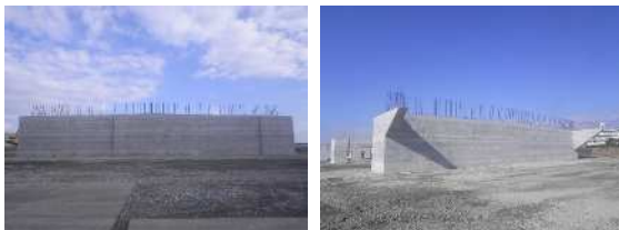
写真-15 目視評価を実施した躯体
