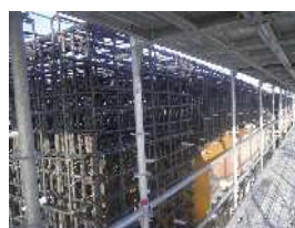
写真-13 配筋状況
