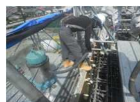
写真-14 余剰水吸引状況
