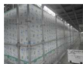
写真-12 養生完了
