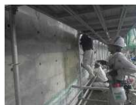
写真-11 養生作業状況
