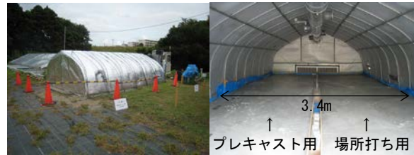
写真-4 養生状況 (外観) 写真-5 養生状況 (内部)
