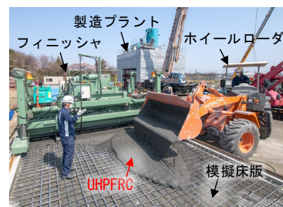
図-3 実物大実験 施工状況
