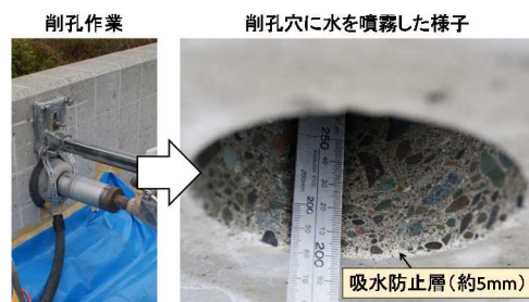
写真-1 削孔による直接的な吸水防止層の確認例
