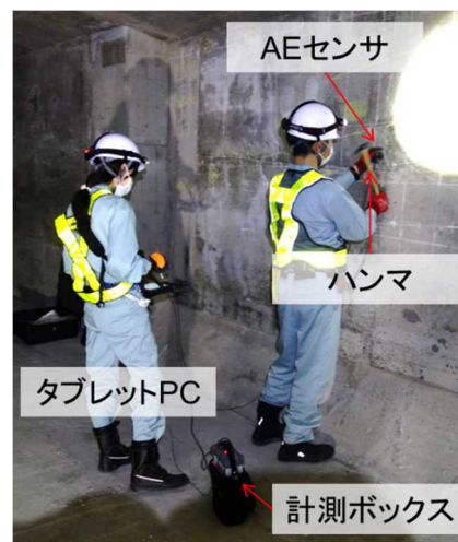
図-3 AE センサを用いた打音検査状況
