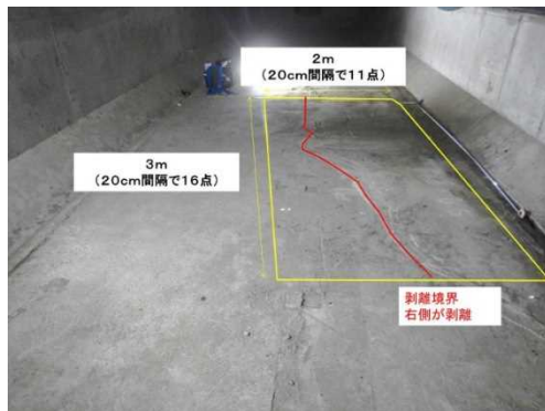
図-6 箱桁下床版の調査箇所
