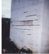
(d) 橋脚側面 (沖縄)
