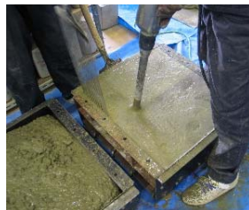
(b) 床部材の締固め
