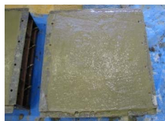
(c) 54-164 の床部材上面の表面仕上げ後の状況
