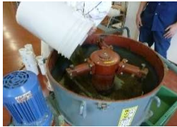
①モルタルの練混ぜ
