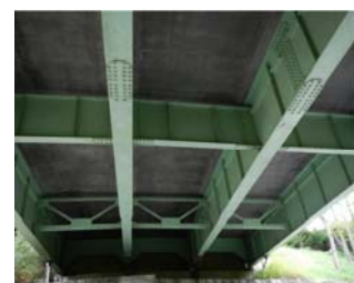
写真-8 床版下面写真
