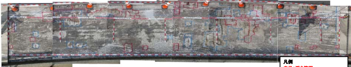
写真-10 舗装開削後オルソ画像
