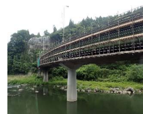
写真-4 大規模な仮設足場の設置事例
