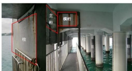
写真-1 A 火力発電所
