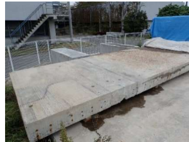
図-19 撤去床版の外観
