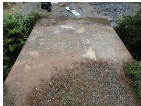
写真-2 橋梁上面での測定点の設定状況
