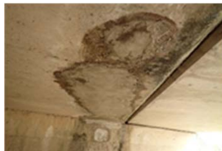
(c) 断面修復材の充填後
