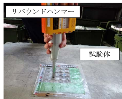
写真-1 反発度に基づく方法の測定状況
