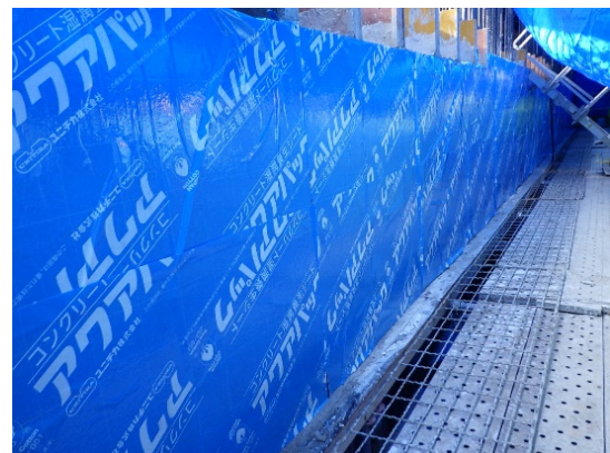
写真-4 湿潤養生シートの現場適用状況
