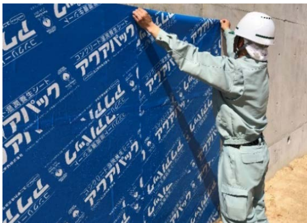
写真-2 貼り付け状況
