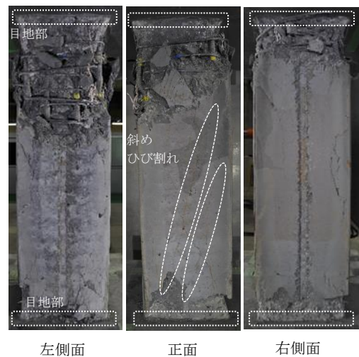
写真-2 鋼板撤去後の損傷状況 (No. 1-2)
