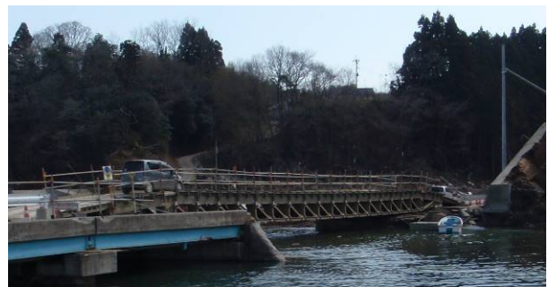
写真-1 緊急仮設橋の例 3)
