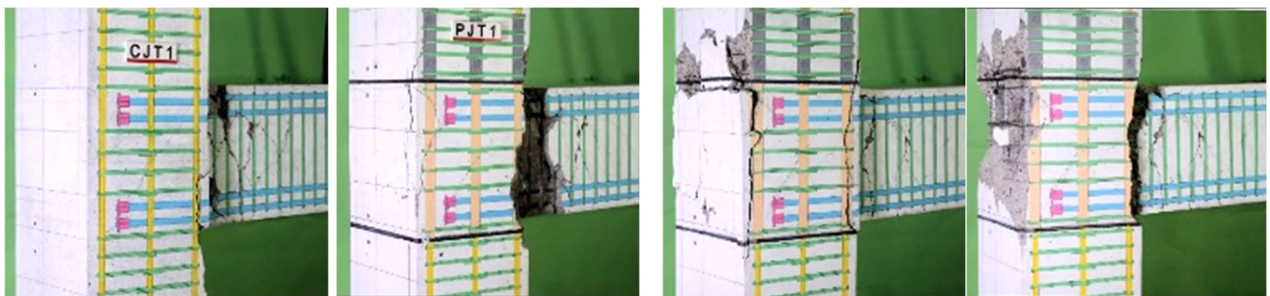
写真-2 最終破壊状況の比較 (CJT1, PJT1, PJT2 試験体)
