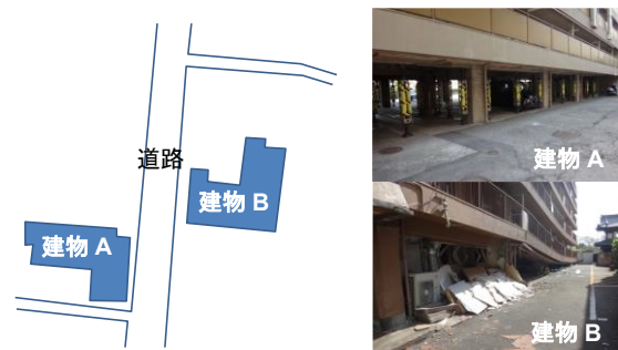
図-1 2016 年熊本地震の被害の一例
