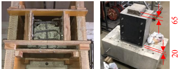
写真-3 著しく損傷した試験体の補強状況
