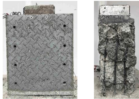
写真-5 荷重後補強試験体 R19-1-PP1-EP の状況
