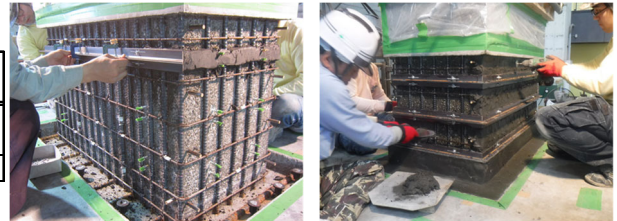
写真-1 目地の設置
