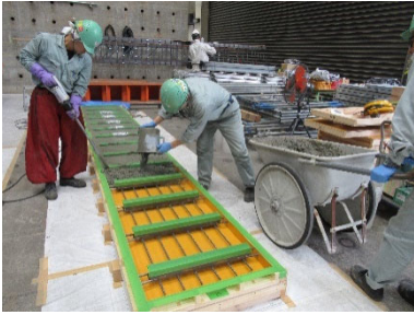
写真-1 PCa版の製作状況
