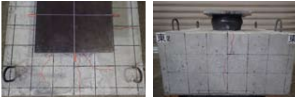
(b) F9-B の RC パイルキャップ上面・側面（東面）
