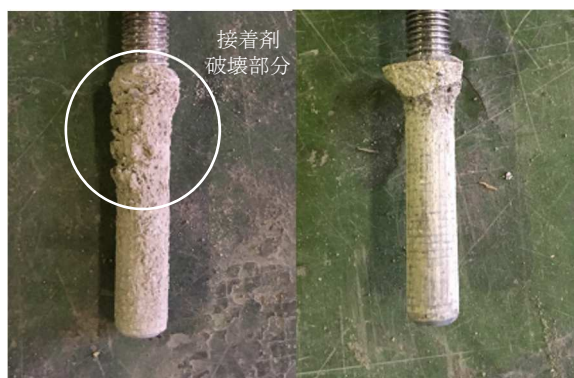
(a) アンカー筋と無機系接着剤間の付着破壊と無機系接着剤の破壊が混在 (b) アンカー筋と無機系接着剤間の付着破壊
