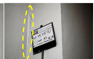
写真-4 劣化度 II の例
