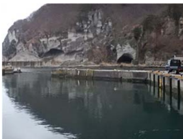
図-7 B 漁港防波堤の外観
