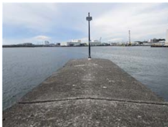
図-5 A 漁港防波堤の外観
