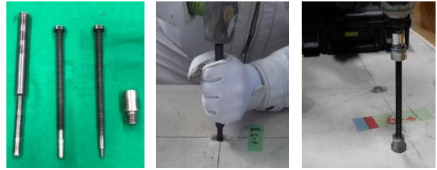
写真-3 アンカー抜き取り用部品および作業状況
