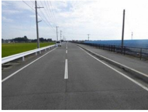
写真-3 橋面の状況
