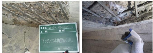
写真-5 既設コンクリートの下地面にEVA系プライマーを噴霧機で塗布する状況（業者施工）
