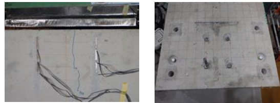
(a) 試験体側面 (b) 落橋防止装置設置面
