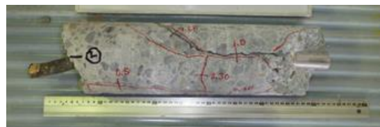
写真-9 ケース 2 コア採取状況
