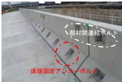
写真-2 開発したフルプレキャスト壁高欄
