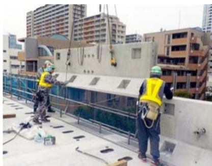
写真-5 壁高欄のブロック架設
