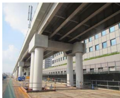
写真-6 工事完成状況
