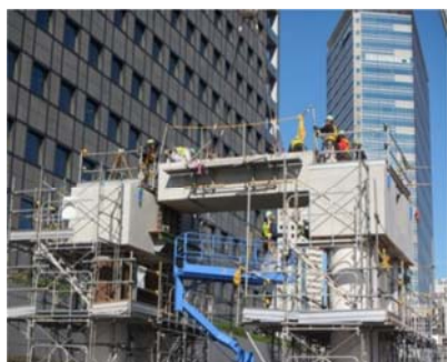
写真-4 横梁ブロック架設
