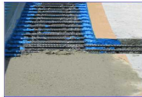
(4) 付着用接着材の塗布 (軸方向)
