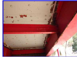
(3) 鋼板接着補強
