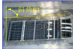
(1) 取替RC床版型枠
