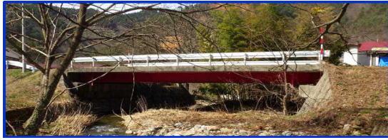
(1) 赤山橋（支間16.1m、有効幅員7.0m、斜角83度）
