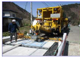
(2) コンクリート練り混ぜ
