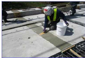
(3) 間詰部コンクリート 打ち込み・表面仕上
