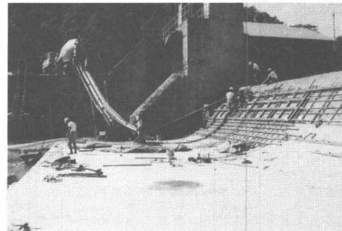
写真-2 コンクリートの現場小運搬
