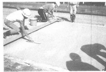
写真-1 ポリマー超速硬セメントコンクリートの施工状況
