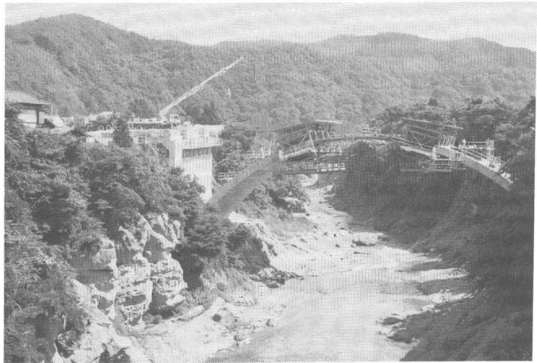
写真-2 アーチリブの巻立て作業
