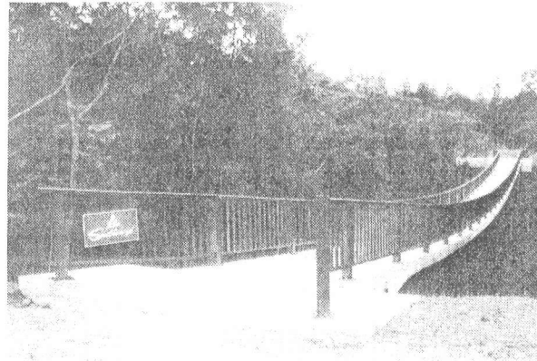
写真-1 吊床版橋
