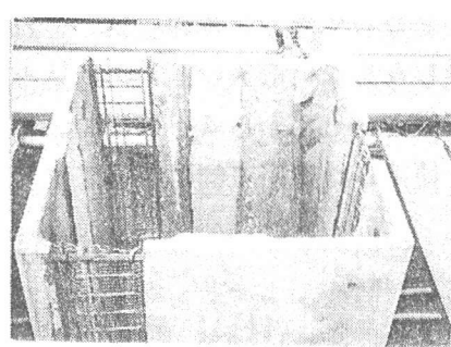
写真-2 開口部のある柱型枠
