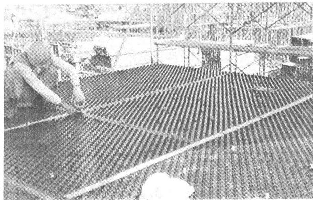
写真-5 発電所中和槽で採用した大型パネル
