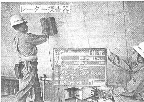
写真-2 レーダー法による探査
