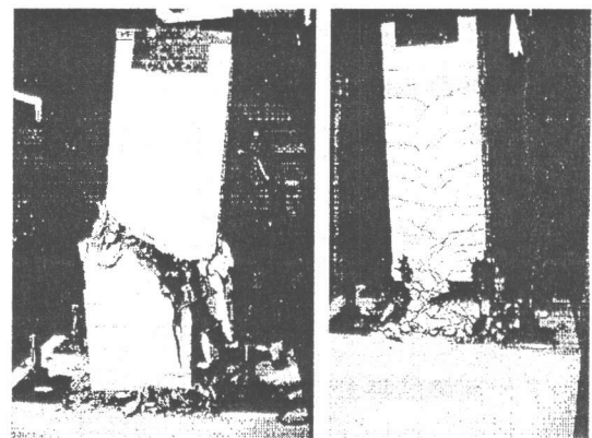
供試体A 供試体B (13 \delta_y ) 写真-1 供試体の破壊状況
