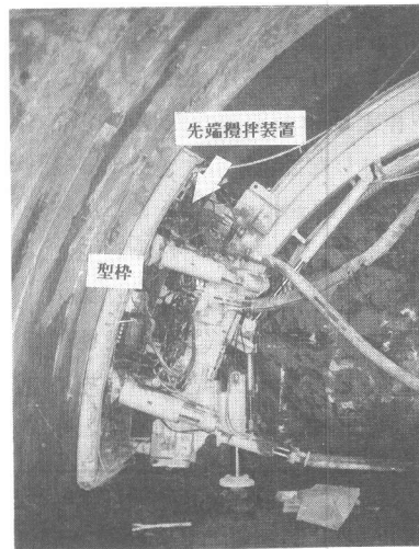
写真-2 先端攪拌装置
