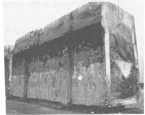
写真-1 約73年経過したケーソンの外観
