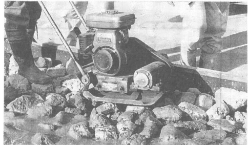
写真-2 ケーソン蓋コンクリート (転圧時)
