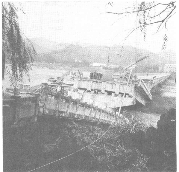
写真-1 長庚大橋落橋状況
