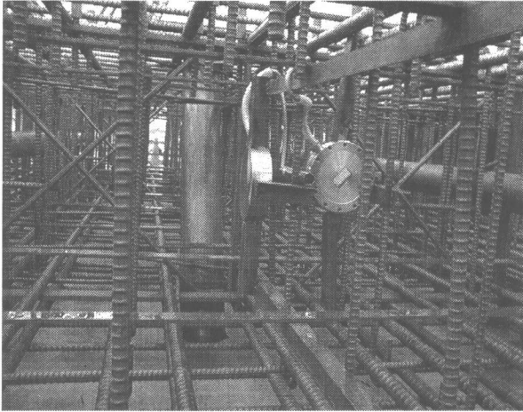
写真-1 土圧計取付け状況
