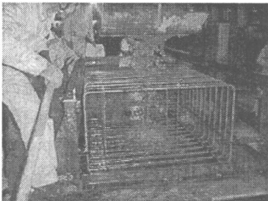
写真-2 コンクリート打設状況
